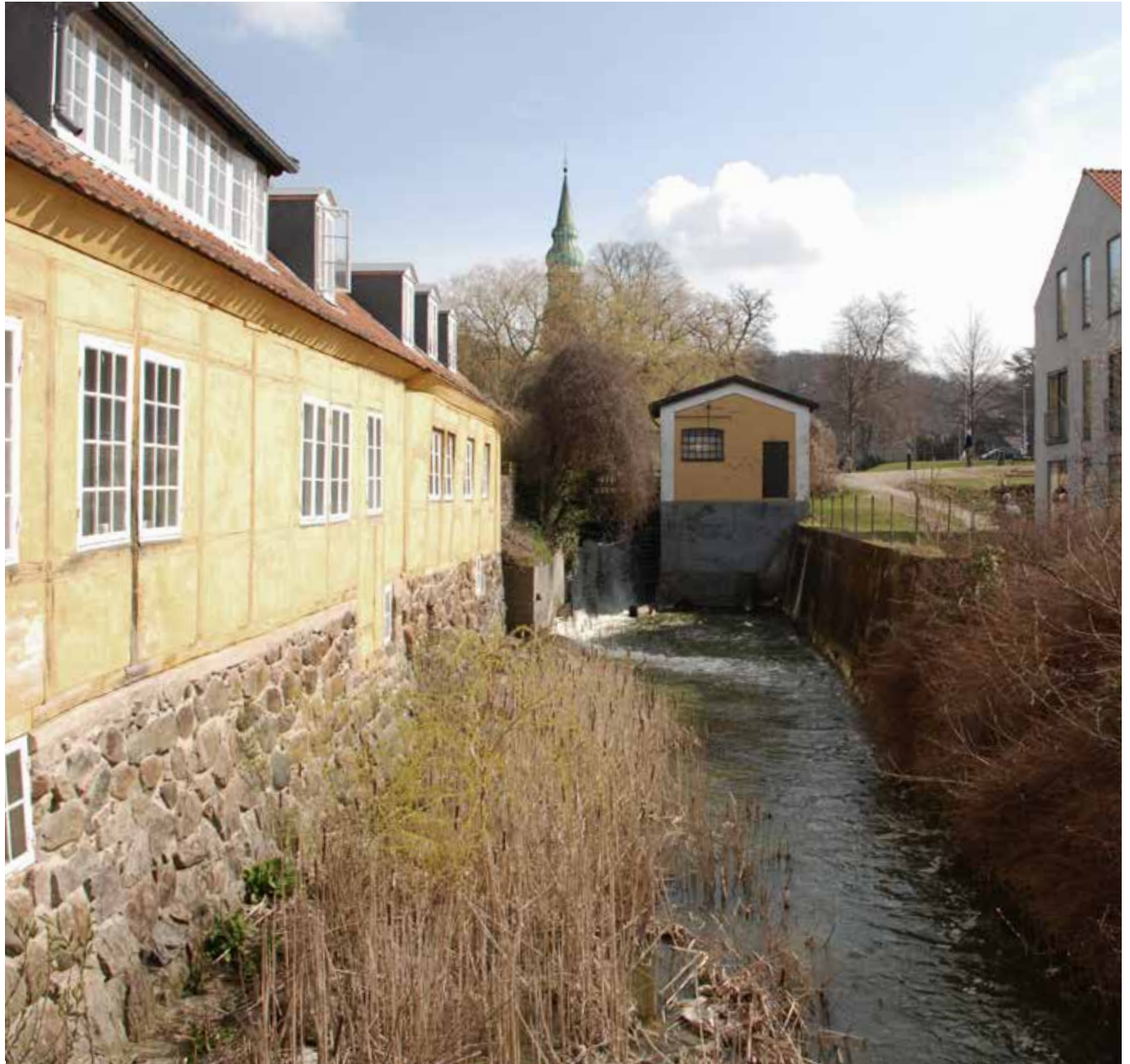
Al afvanding fra Arresø til Roskilde Fjord sker via kanalen, som bl.a. løber gennem Frederiksværks bymidte og det historiske miljø omkring Strandgade.
